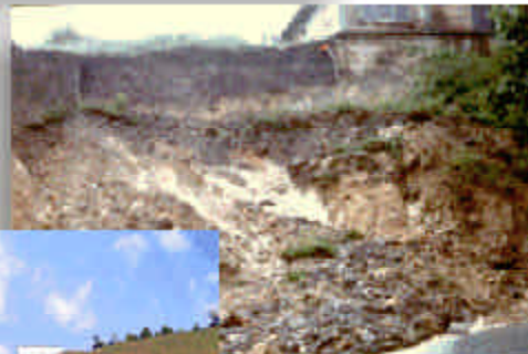
Figura 2. Desprotección de un talud mediante quema de la vegetación
