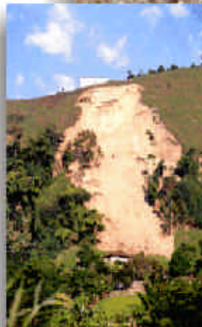
Figuras 3 y 4. Remoción masal causada por mal manejo de aguas, lo cual pone en riesgo construcciones y vidas humanas.
