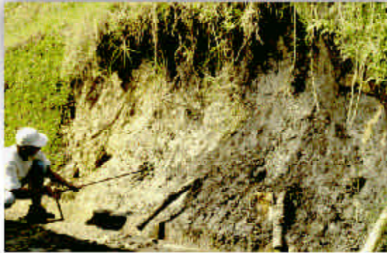
Figura 19. Construcción de un filtro con materiales de guadua y gravilla.
