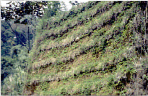
Figura 15. Cubrimiento parcial del talud con césped. El espacio libre entre franjas de césped es cubierto con estolones de Arachis pintoi .
