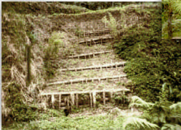
Figura 16 y 17. Trinchos vivos en forma escalonada acompañados de filtros vivos de guadua o quiebrabarrigo, para estabilización de talud con horizontes inestables de arena.
