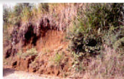
Figura 7. Desestabilización de talud debido al desprendimiento de la vegetación que lo cubre y a la poca capacidad de amarre de coberturas como el pasto elefante
