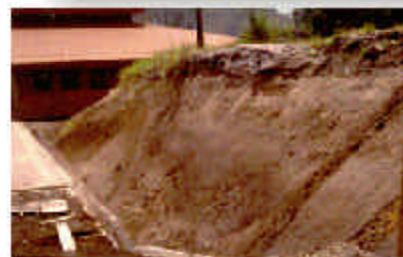
Figura 8. Formación de surcos sobre el talud desnudo, debido al escurrimiento de aguas superficiales
