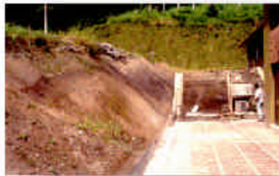
Figura 5. Talud desprovisto de vegetación, expuesto a la erosión por impacto directo de las gotas de lluvia.
