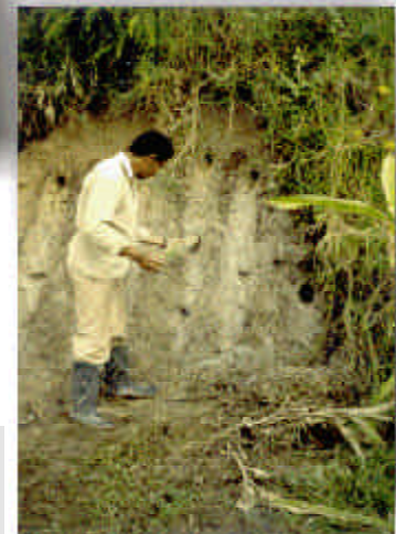
Figura 20. Introducción de filtro horizontal en el talud.
