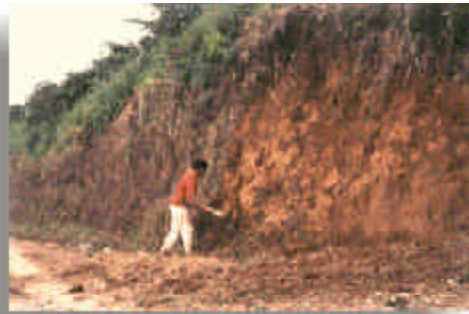
Figura 1. Desyerba indebida de un talud, con azadón
