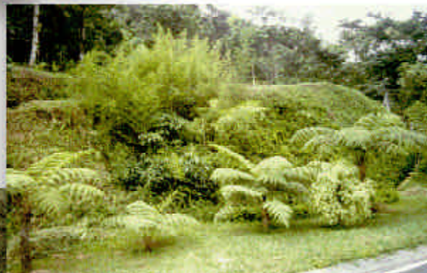
Figura 15. Cubrimiento parcial del talud con césped. El espacio libre entre franjas de césped es cubierto con estolones de Arachis pintoi .
