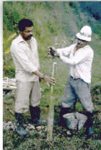
Figura 19. Construcción de un filtro con materiales de guadua y gravilla.
