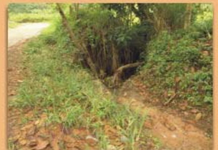
Ausencia de cajas recolectoras en caminos o carreteras y entrega inadecuada de aguas a media ladera; frecuencia 52%
