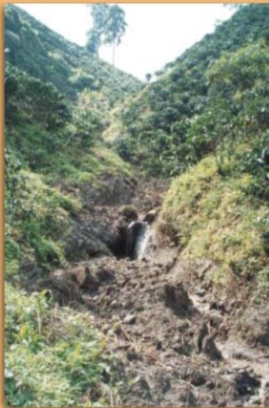
Figura 2. Desprotección de los drenajes naturales; frecuencia 58%
