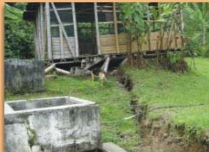
Agrietamientos de canales o tanques de almacenamiento de agua; frecuencia 13%
