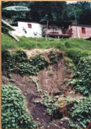
Viviendas sin canalización de las aguas de los techos; frecuencia 23%
