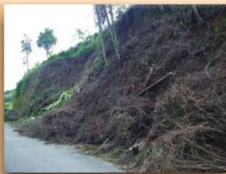
Desprotección de taludes por medio de desyerbas intensivas frecuencia 13%
