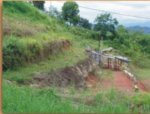
Conformación de terraplenes sin las debidas medidas de drenaje; frecuencia 3%
