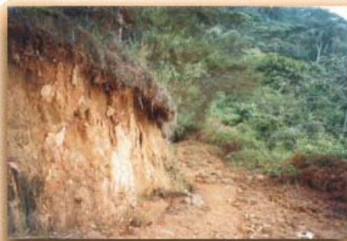
Presencia de escapes en taludes de alta pendiente; frecuencia 6%
