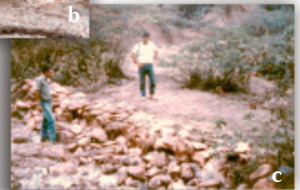
Figura 1. Trinchos en concreto (a); en gaviones en piedra (b); y en piedra (c).
