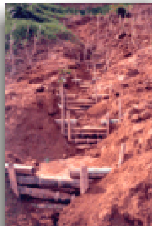
Figura 3. Trincho sin amortiguador (babero).
