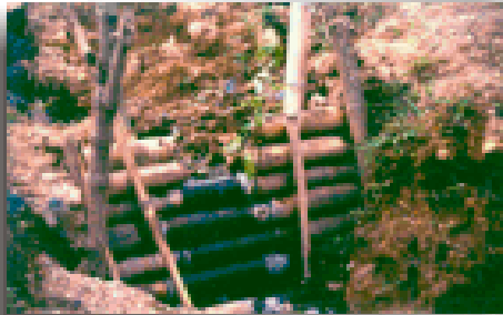
Figura 2. Trinchos mal construidos con vertedero muy pequeño o sin él.
