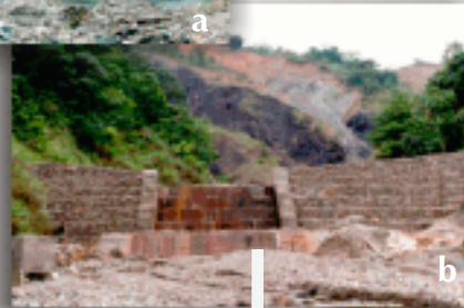
Figura 1. Trinchos en concreto (a); en gaviones en piedra (b); y en piedra (c).
