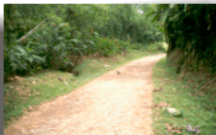
Figura 7. Cunetas protegidas por cobertura vegetal
