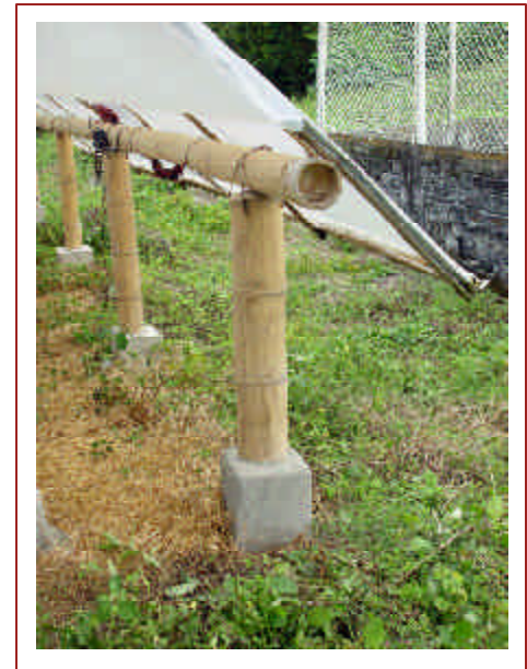
Figura 9. Columna revestida en concreto para soporte lateral de la cubierta
