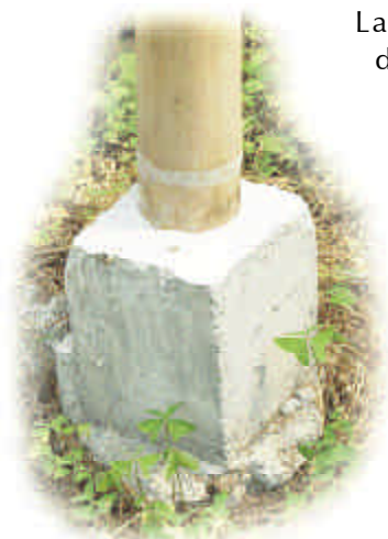
Figura 4. Columna en guadua revestida en concreto
