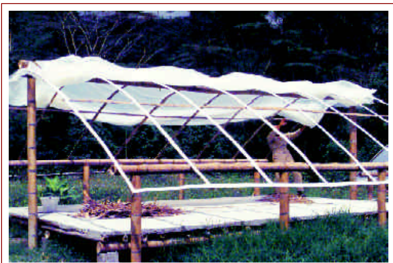
Figura 10. Entramado en latas de guadua para soporte de la cubierta
