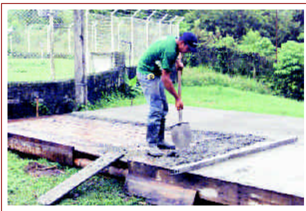
Figura 8. Placa del piso en concreto 1:2:4. Acabado fino y liso con paleta o llana.
