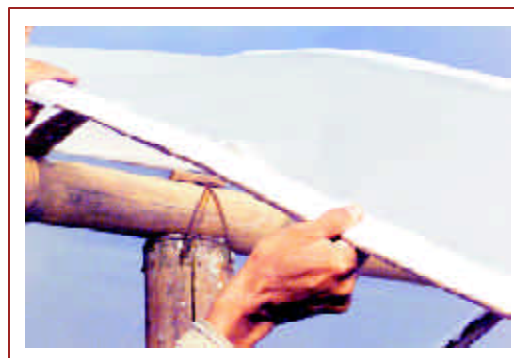
Figura 11. Templado e instalación del plástico para la cubierta en el caballete.
