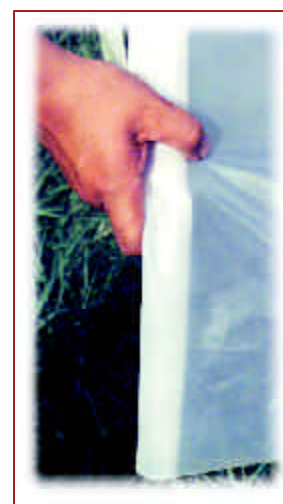
Figura 12. Sistema de templado del plástico en las latas de guadua
