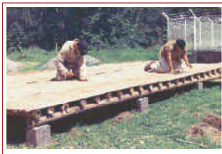
Figura 6. Piso en entramado de guadua, con esterilla
