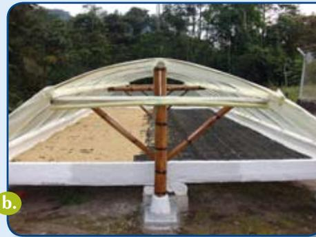
**Figura 2.** Soportes en cruz interior (a) y exterior (b).
