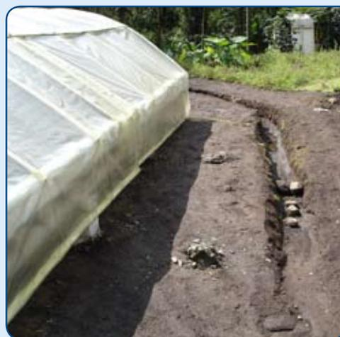
**Figura 7.** Drenaje para desviar el agua de escorrentía.
