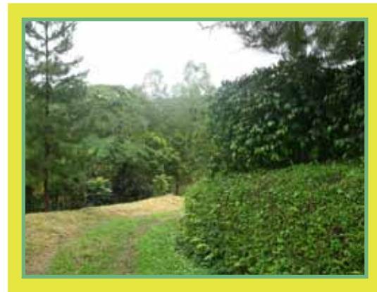
Figura 12. Cunetas revestidas con cobertura vegetal.
