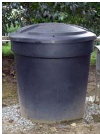
Figura 13. Tanque de polietileno utilizado como reactor metanogénico.
