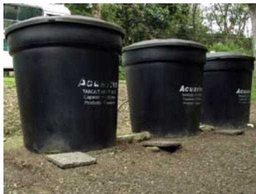
Figura 4. Reactores Hidrolíticos-Acidogénicos en tanques de polietileno.
