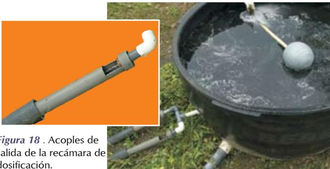
Figura 18 . Acoples de salida de la recámara de dosificación.
