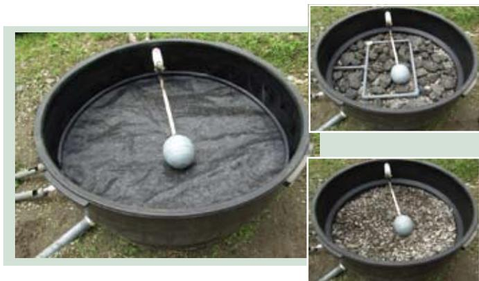
Figura 11. Acondicionamiento interior de la recámara de dosificación.
