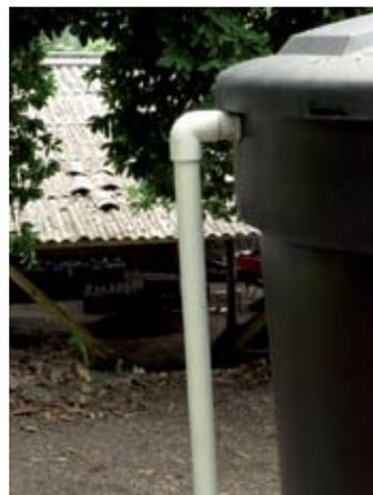
**Figura 7.** Tubería de seguridad para rebose de ARL.
