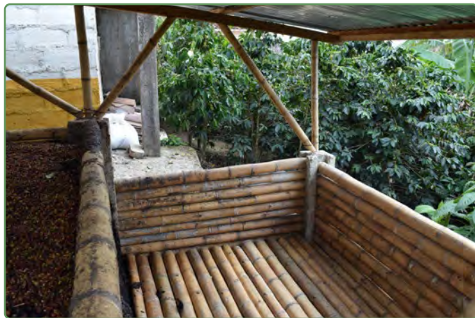
Figura 7. Falso piso del procesador elaborado en guadua o madera rolliza.
