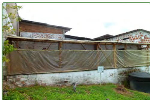
4. Forrar en plástico las paredes del procesador.
