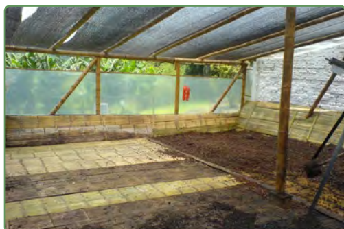
3. Instalar el falso piso en esterilla y con pendiente del 2% para recolectar lixiviados.
